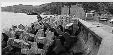
防波堤護岸の改善
